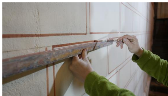
Finalisation décors mur sud.
